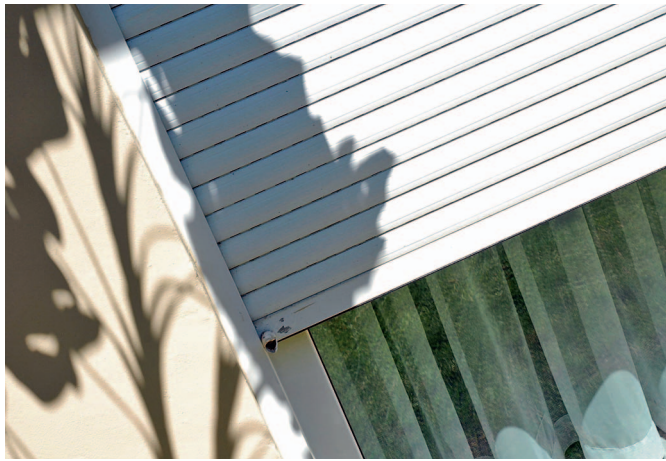
Bild 3. Eine aktuelle Studie des ITRS belegt, dass automatischer Rollladen- und Sonnenschutz erheblich zur Verringerung des Heizwärmebedarfs beiträgt und die Kosten zur Kühlung des Gebäudes verringert. (Abb./Fotos: Somfy)
